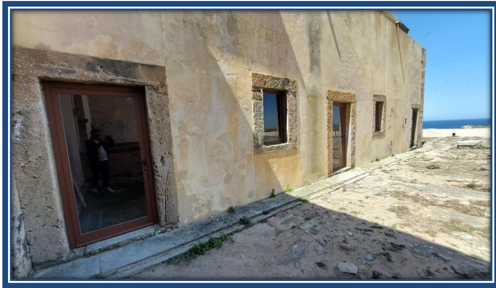
Colocação de portas e janelas nas salas de exposição do Forte do Pessegueiro
