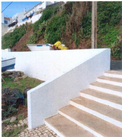
Pintura das escadas
