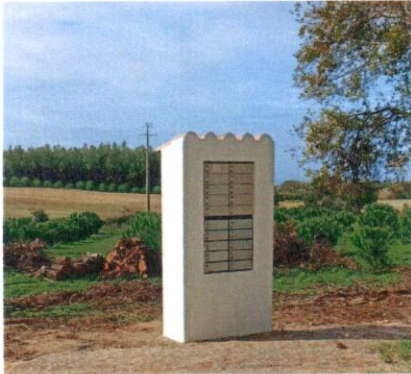
Construção das caixas postal Boa Vista do Vale Travessinho/ Serra de Baixo
