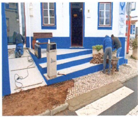
Realização de obras para melhoria do acesso a pessoas com mobilidade reduzida
