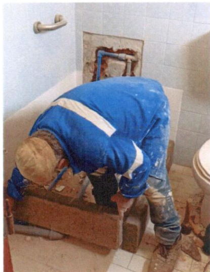
Reparação da casa de banho e substituição da canalização
