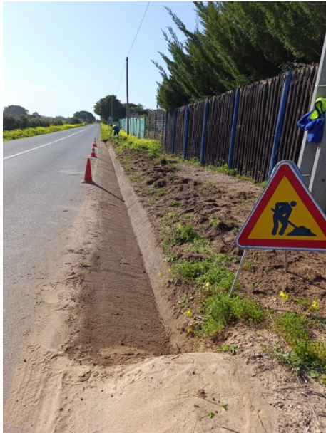
Limpeza de valetas – EM 544
