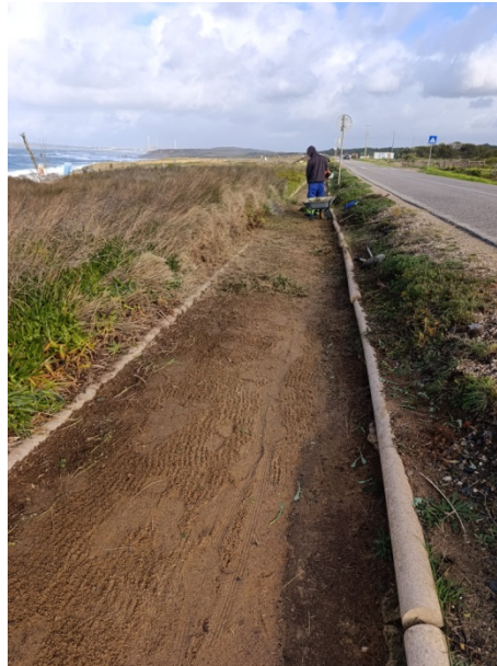
Limpeza do Circuito de manutenção
