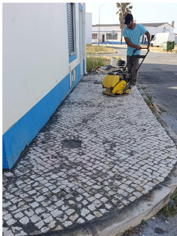
Colocação e reparação de calçada
