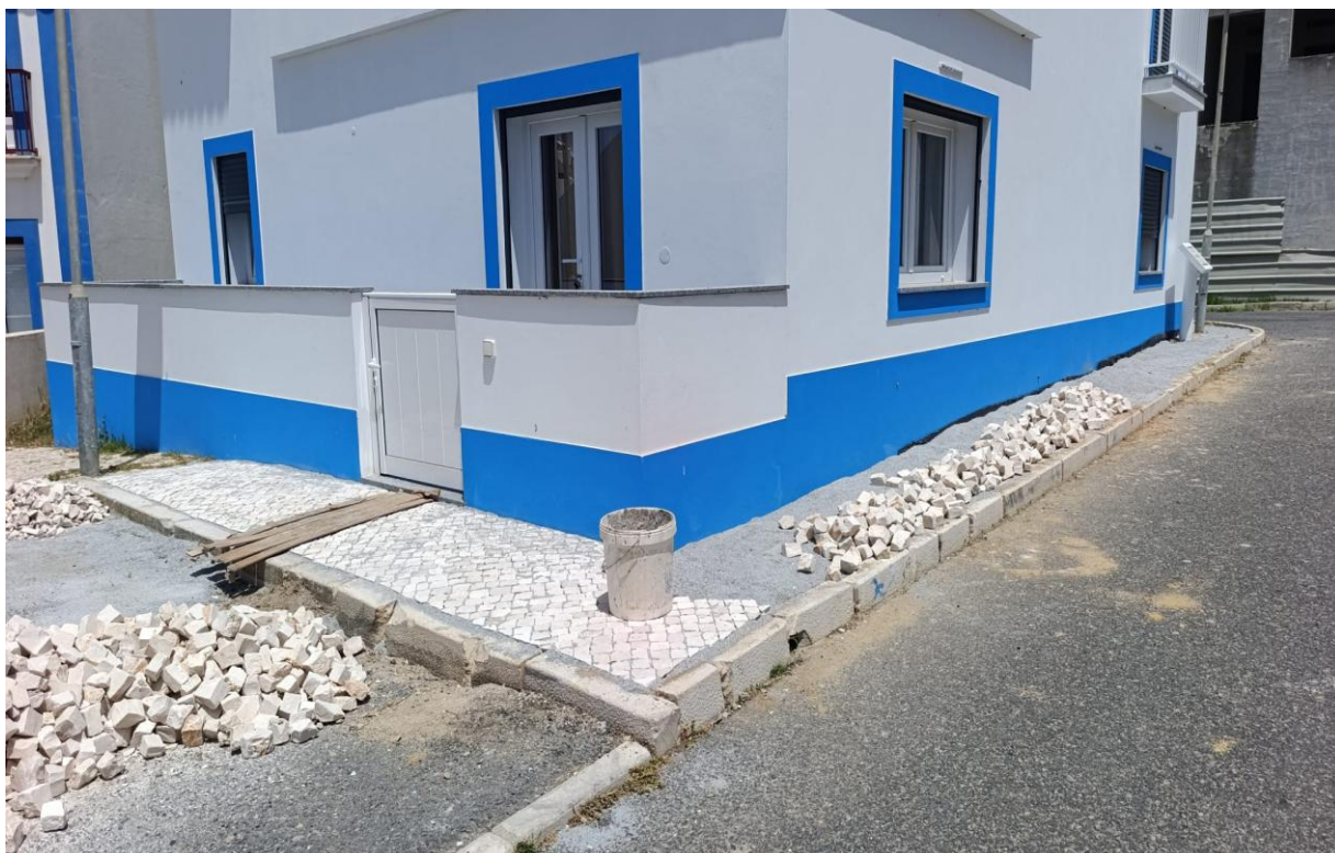
Colocação e reparação de calçada
