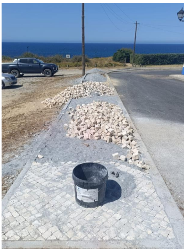
Colocação e reparação de calçada
